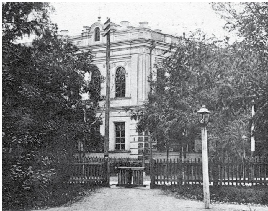
Рис. 3. Домовий храм Олександра Невського в будівлі Кремен- чуцького реально- го училища (добре видно маківку церкви із хрестом).
