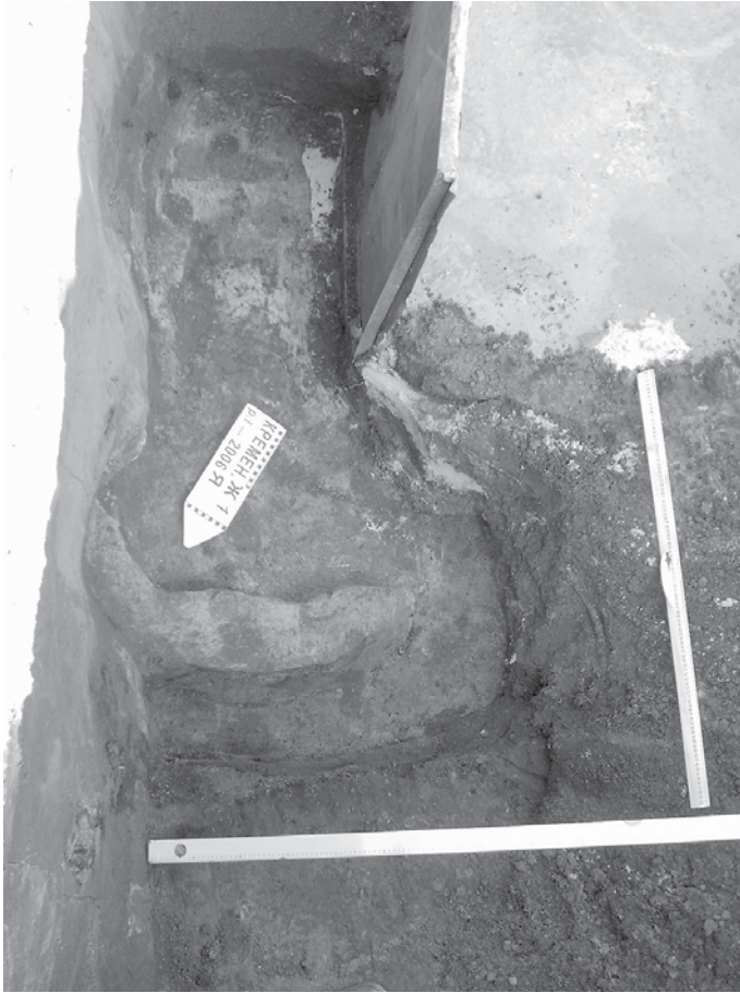
Рис. 11. Кременчук, м., вул. Генерала Жадова, 1в. Розкоп 1/2006 р. Рештки печі у підкліті давньоруського житла. Робочий момент досліджень. З північного заходу.
